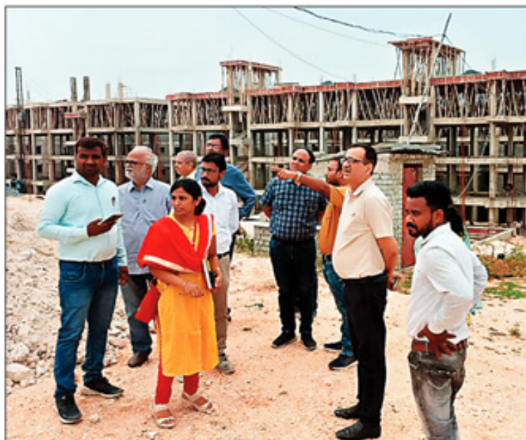
चास नगर निगम क्षेत्र अंतर्गत निर्माणाधीन कालापार किरफायती आवास परियोजना के कार्य प्रगति का निरीक्षण करते डीएम के अधिकारी।
