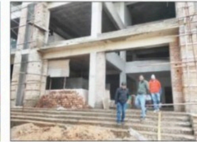
डीएम लाइब्रेरी का निर्माणाधीन भवन।
